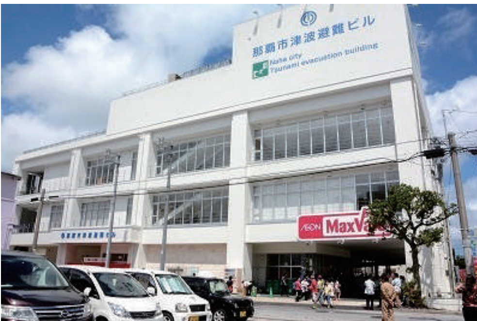
那覇市津波避難ビル（那覇市松山 2-22-1）
